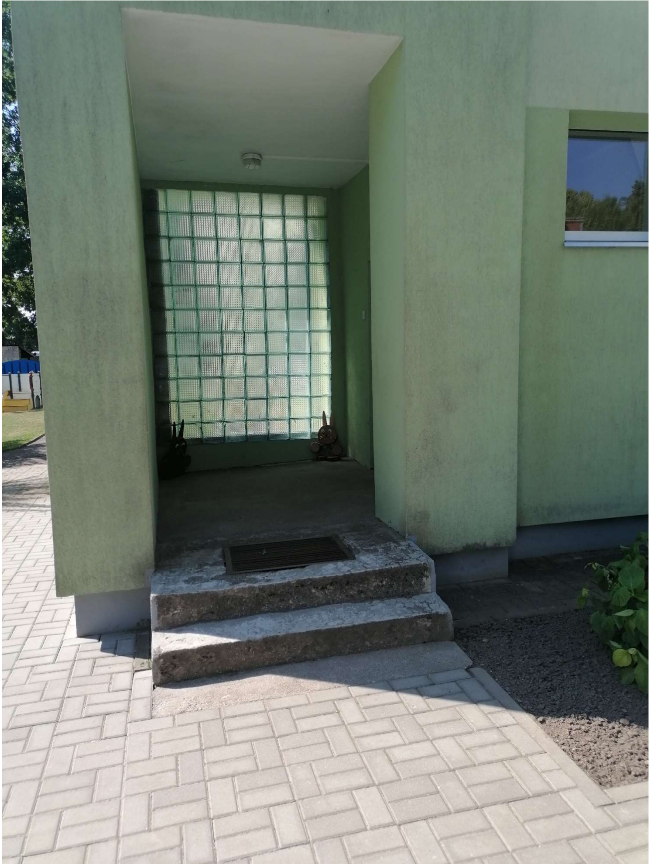
3. Pav. Šiaurinis fasadas (įėjimas į pastatą)
